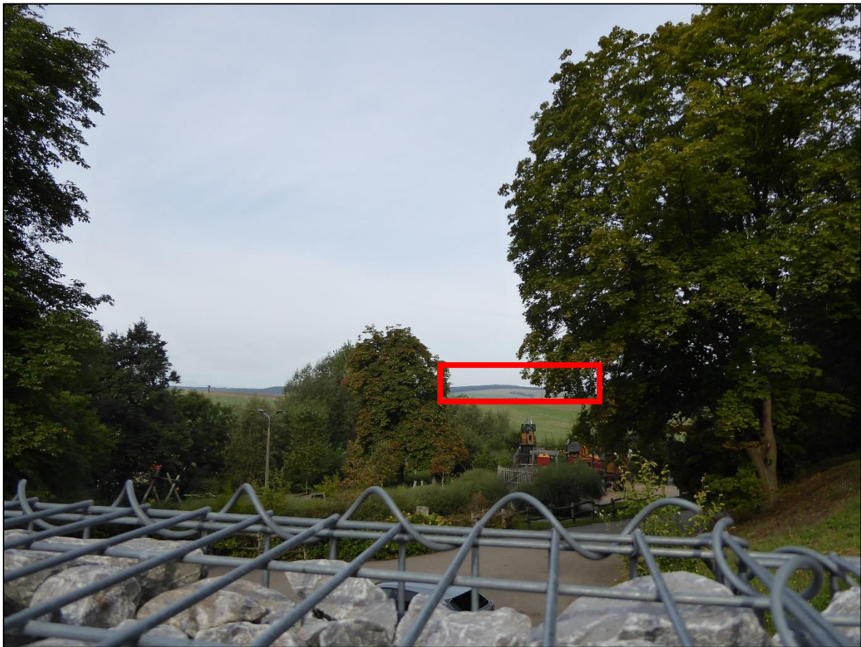
Abb. 4: Blick auf die Agri-PV-Anlage von der Treppe zur Gastronomie
