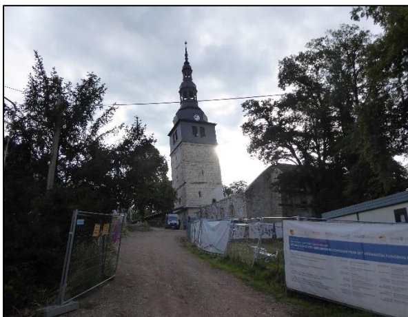
Abb. 29: Schieferturm, Blickrichtung: Osten
