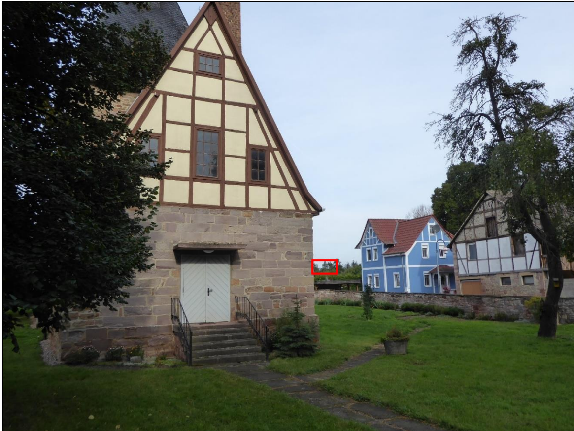
Abb. 2: Blick auf Baumreihe bei der Agri-PV-Anlage von Kirche in Rottleben (Standort 6)
