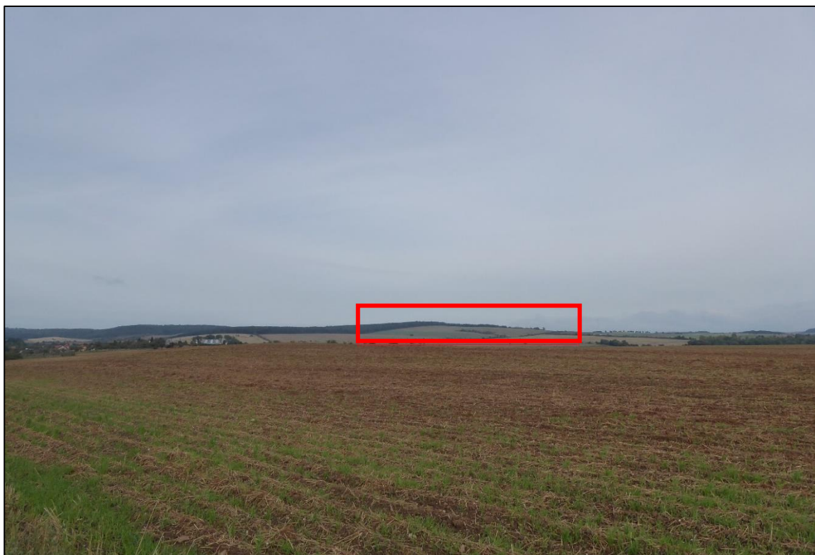
Abb. 10: Blick auf die Agri-PV-Anlage vom Barbarossaweg (Standort 17)
